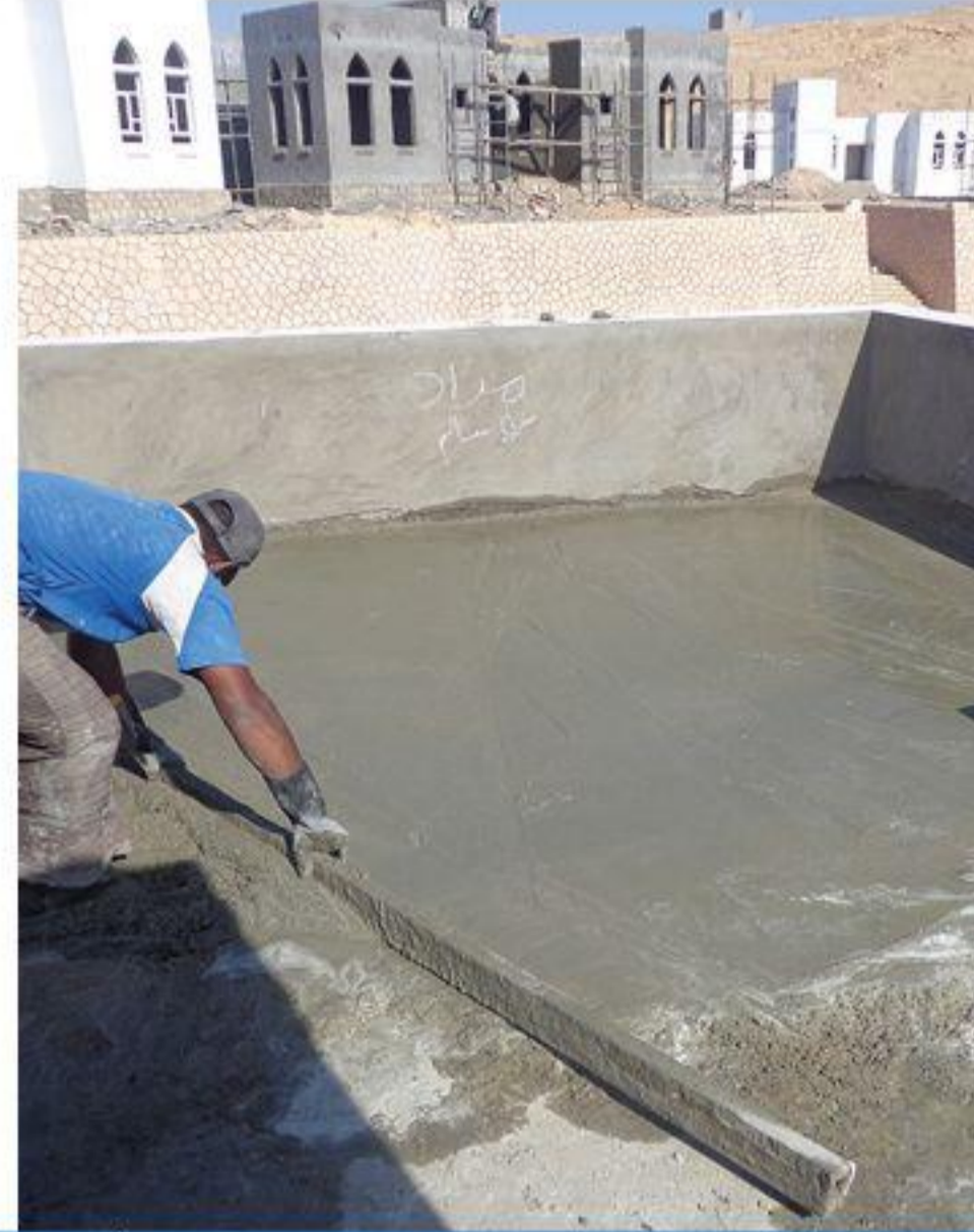
صبّة ميول عازلة للماء و تروبية للأسطح والمساح وخزانات المياه فائقة الجودة جاهزة الخلط للإستخدام على الأسطح الخرسانية
